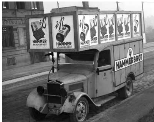
Foto: Archiv Wien Energie Gasnetz
