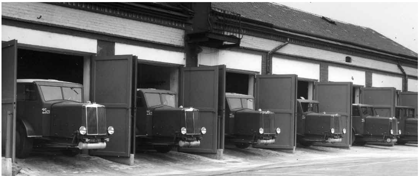
Foto: Archiv Wien Energie Gasnetz
